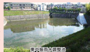
東中振雨水調整池
