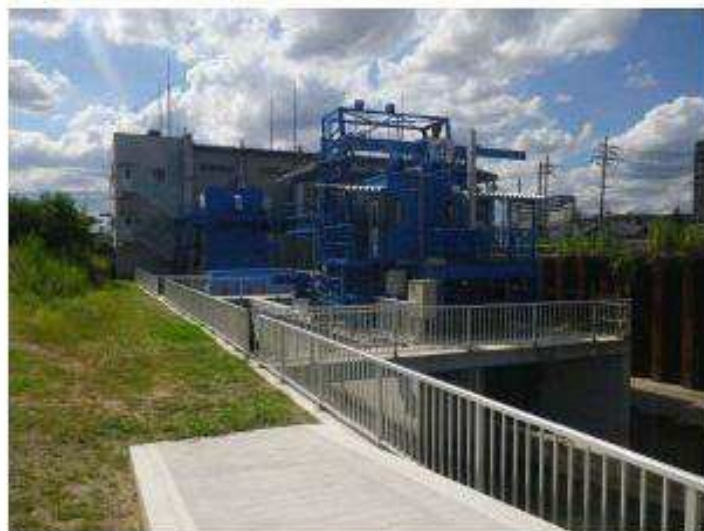
沈砂池、自然吐水路、除塵設備
