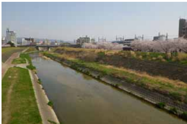
天野川の高水敷整備
