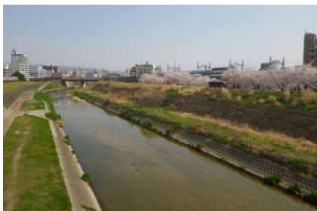
天野川の高水敷整備
