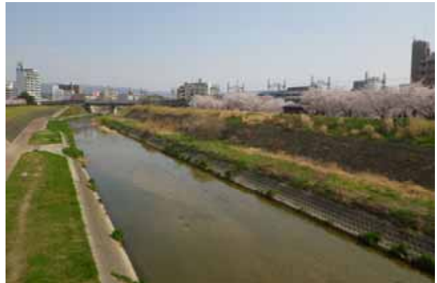
天野川の高水敷整備
