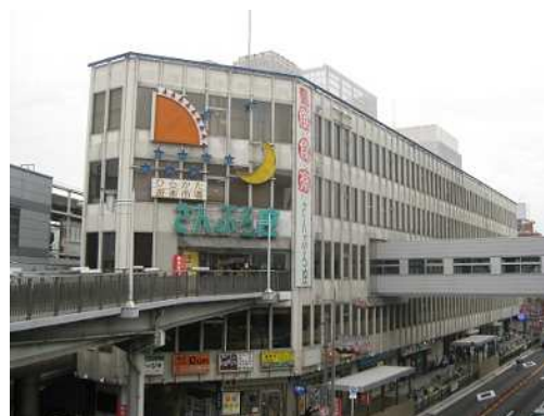
サンプラザ 3 号館
