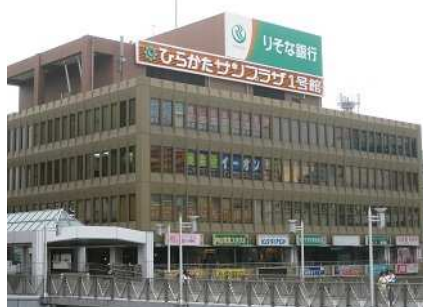
サンプラザ 1 号館
