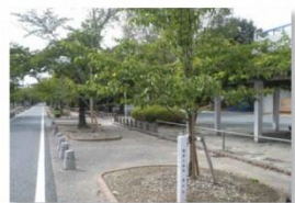
街路樹の再整備（豊川市）
