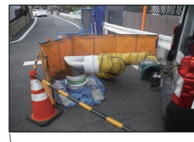
マンホールからの送煙状況
