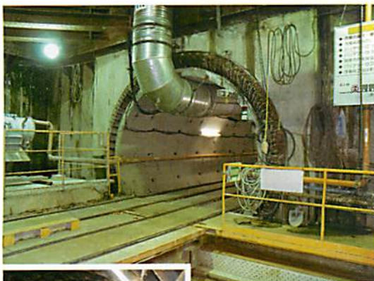
シールド工法による雨水管整備工事の様子（写真は整備済の山田雨水幹線）
