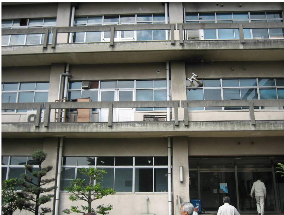
< 管理棟の室内の状況 >
