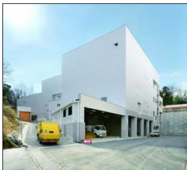
(東部清掃工場 粗大ごみ破碎処理施設)
