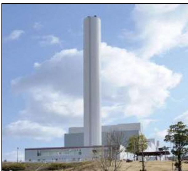
(東部清掃工場 ごみ焼却施設)
