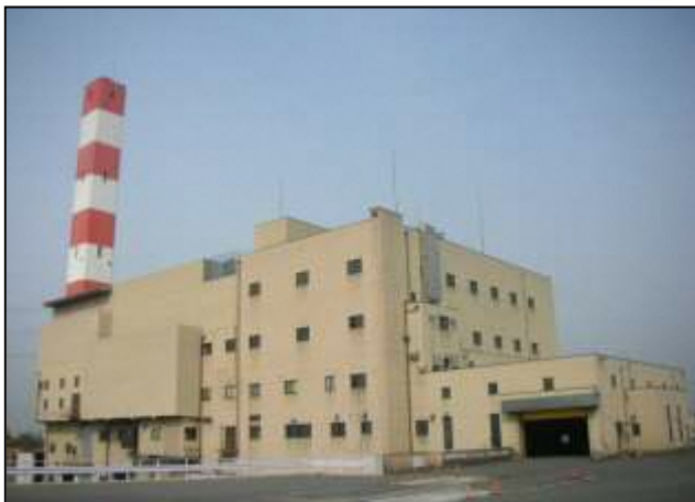
(穂谷川清掃工場)
