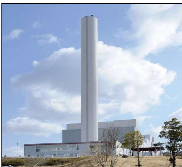
(東部清掃工場 ごみ焼却施設)
