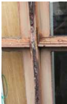
腐食が進む窓枠
