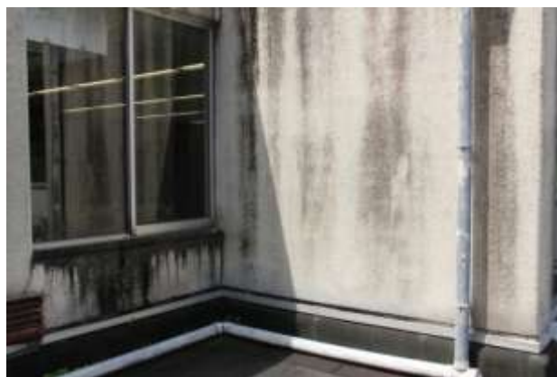
汚れが目立つ壁面
