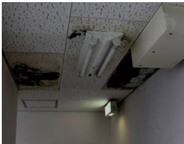
雨漏りによりカビが発生した天井
