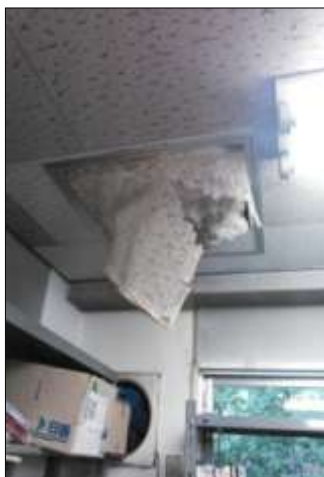
雨漏りが原因で落下した天井
