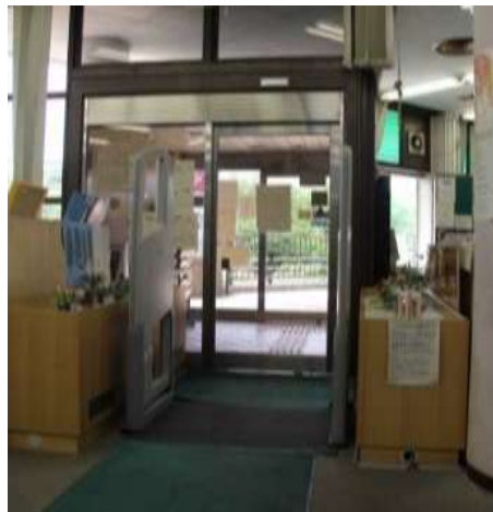
間隔が狭い正面入口の通路
