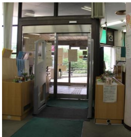
間隔が狭い正面入口の通路
