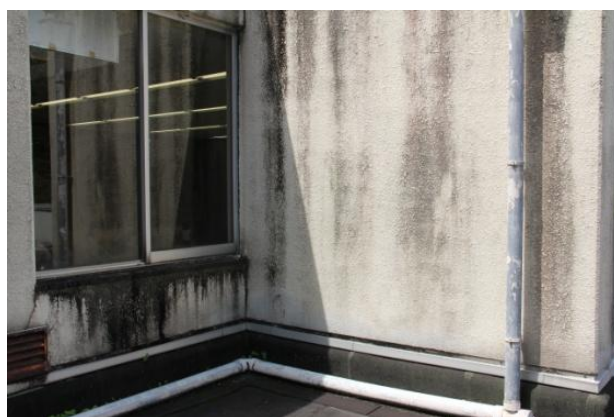
汚れが目立つ壁面
