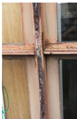
腐食が進む窓枠
