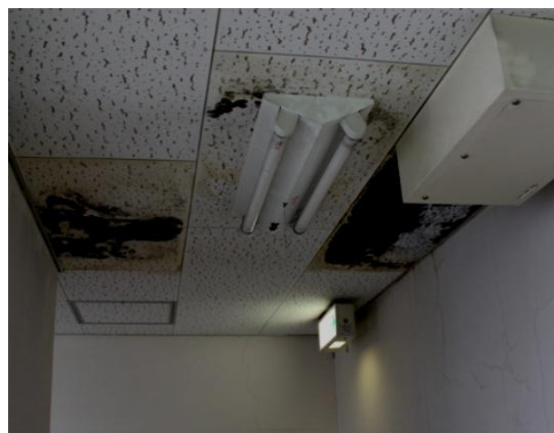
雨漏りによりカビが発生した天井
