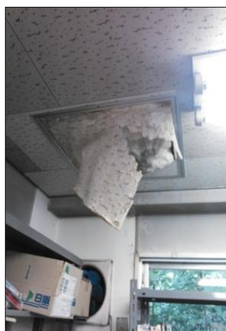
雨漏りが原因で落下した天井
