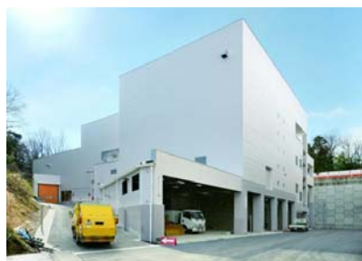
粗大ごみ破碎処理施設
