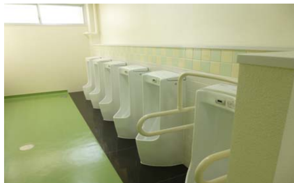
ドライ方式によるトイレ改造（山之上小学校）
