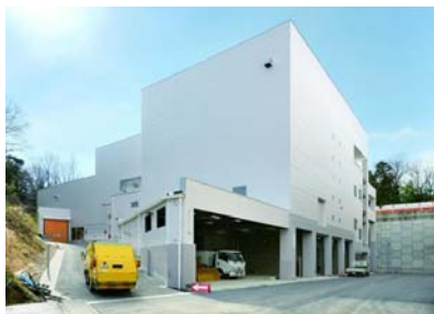
粗大ごみ破碎処理施設
