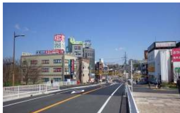
枚方藤阪線（天津橋工区）完成区間
