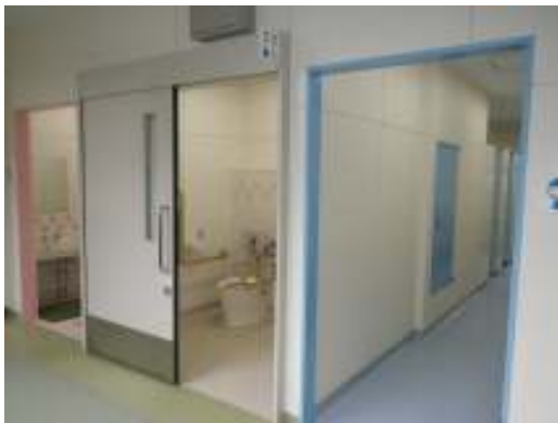
ドライ方式によるトイレ改造
