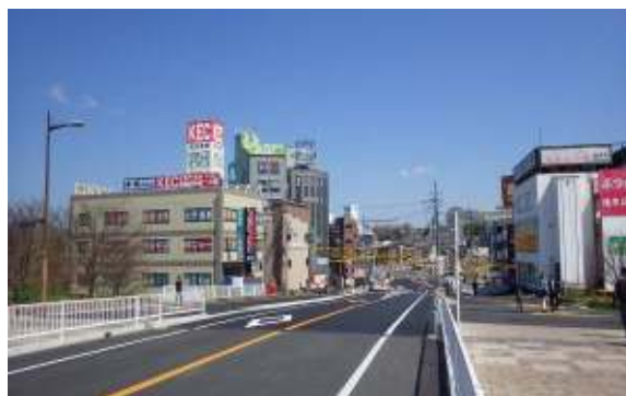
枚方藤阪線（天津橋工区）完成区間
