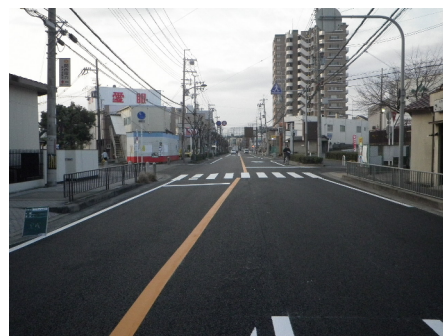
〈整備後の岡東山之上東 1 号線〉
