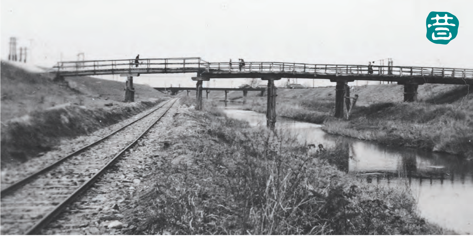
▲土砂を運ぶトロッコ線が走る河川敷（昭和27年）。奥には京阪本線の鉄橋が。手前の橋は翌年コンクリート製に改修され、「天津橋」と名付けられました。
