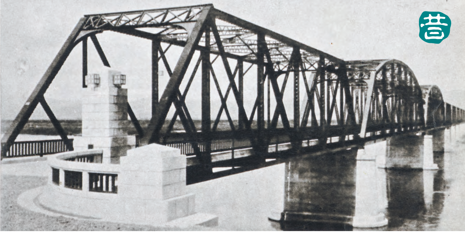
▲古鉄橋を譲り受けて作られました（昭和5年）。
