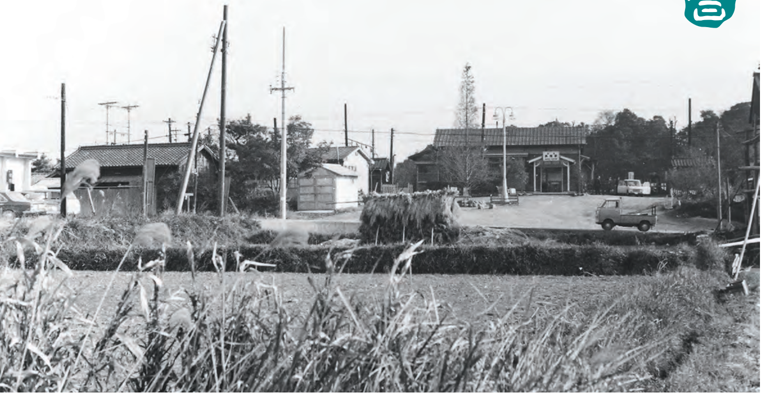
▲昭和40年頃の長尾駅。駅前広場は手前の田んぼに向かって下り坂になっていました。
