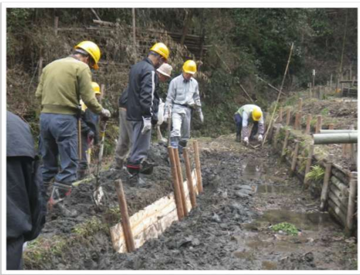
里山道の 修繕作業
