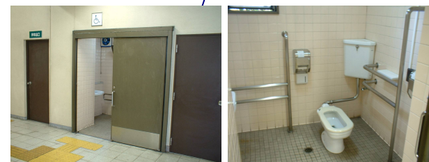
身体障害者用トイレ
