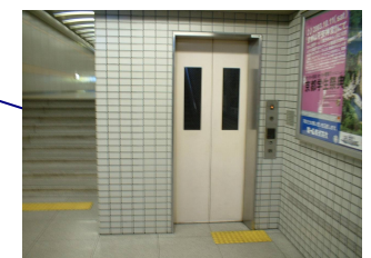
エレベーター（改札内）
