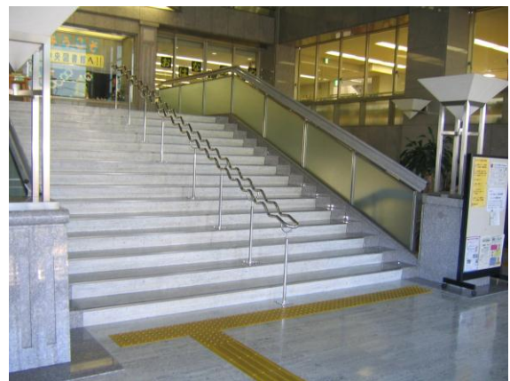
視覚障害者の意見で改善した玄関と2階間の階段手すりと点字ブロック
