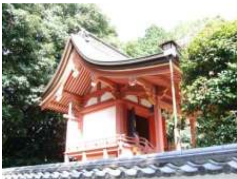
二ノ宮神社本殿（船橋本町1丁目）
