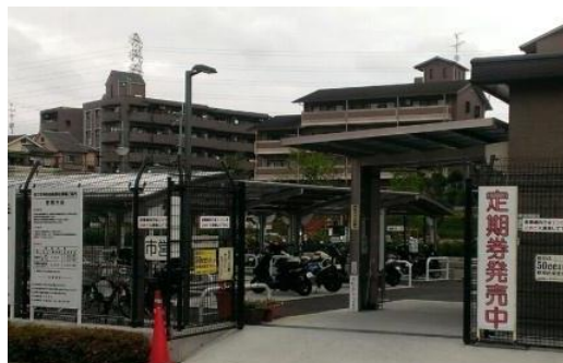
津田東自転車駐車場
