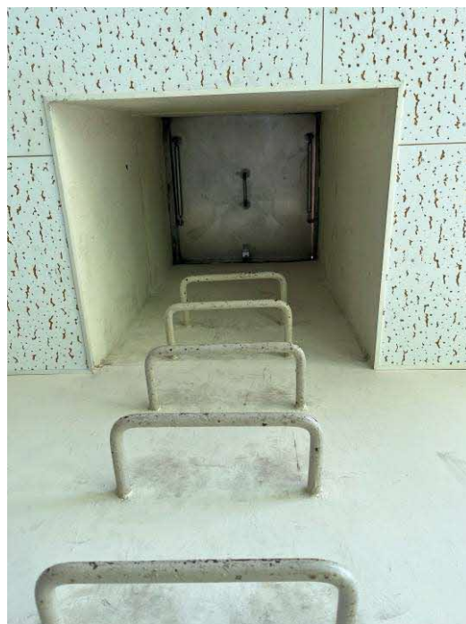
【交北小学校 屋上までの梯子②】
