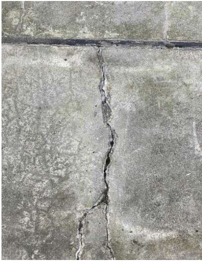
【地下駐車場の壁面崩れ】
