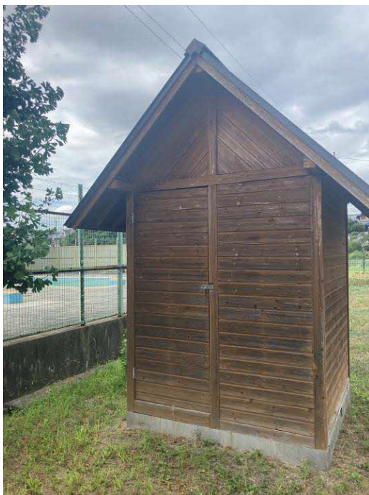
【藤阪小学校 倉庫①】
