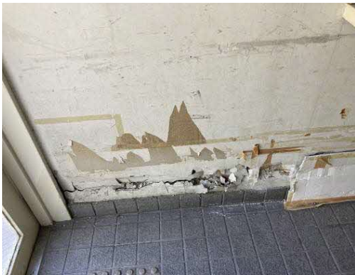
【1階通路下部の壁面崩れ】
