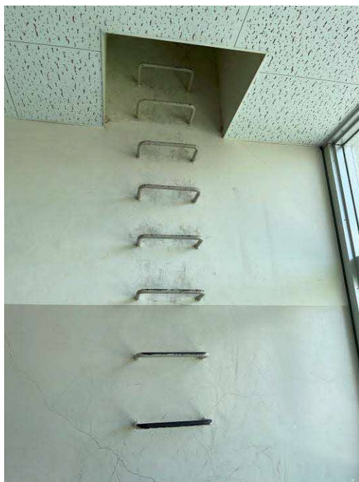
【交北小学校 屋上までの梯子①】
